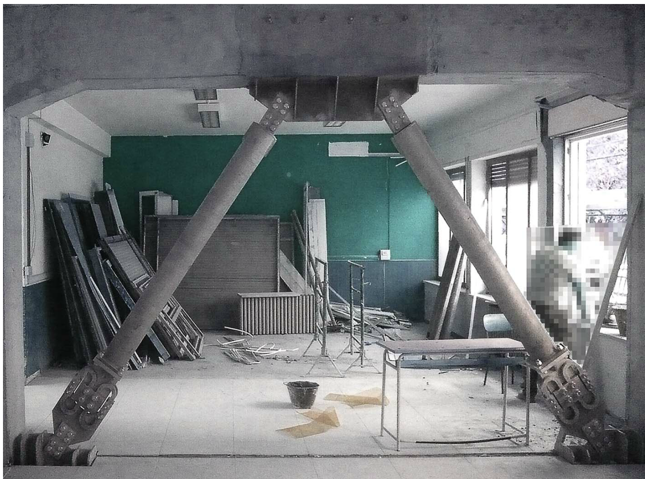
Installazione di controventi dissipativi
